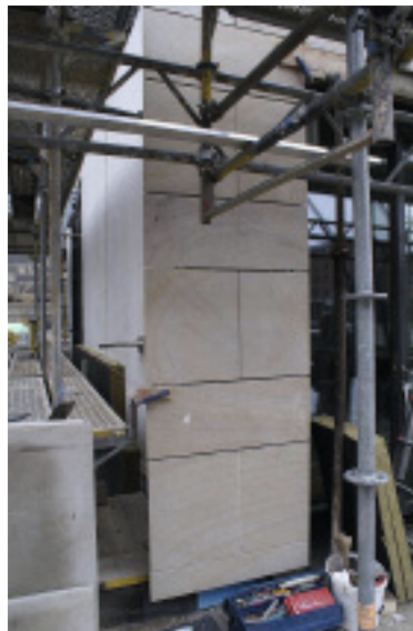
Während der Fassaden-Montage Fotos: Firma Grandi
