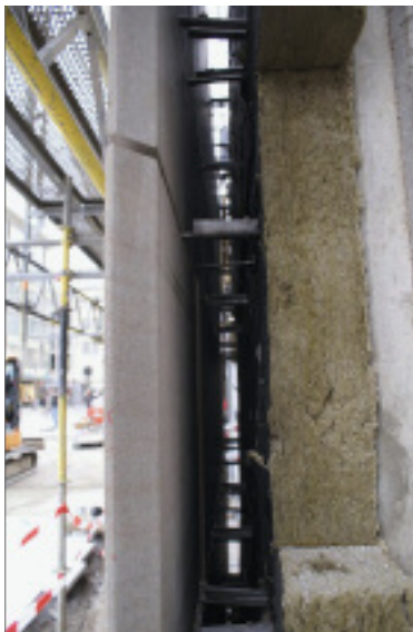
Vorgehängte, hinterlüftete Fassade mit Dämmung
